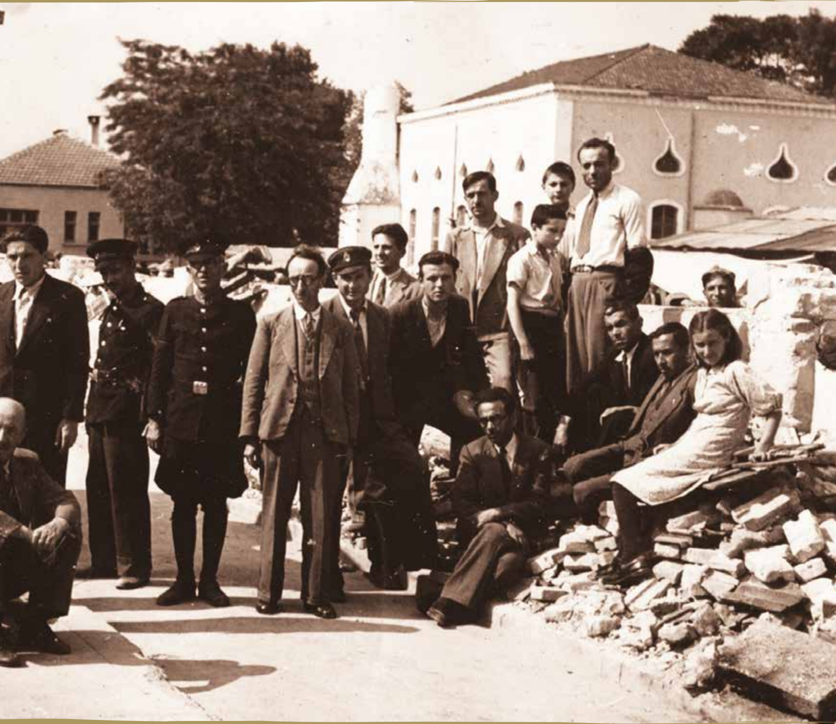
Depremde minaresi yıkılan Orhan Cami
