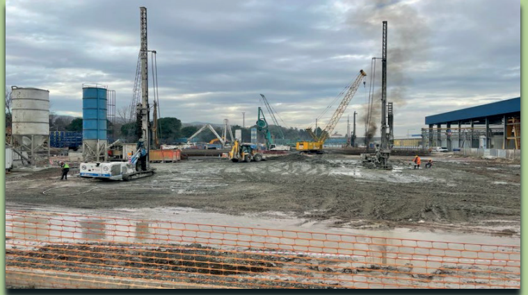
FORD OTOSAN-UMUT İNŞAAT /KOCAELİ/GÖLCÜK FORD OTOSAN-UMUT İNŞAAT OTOSAN KOCAELİ FABRİKASI GÜNEY TEVSİİ BİNASI İNŞAATI (2021-2022) JETGROUT VE FOREKAZIK UYGULAMASI
