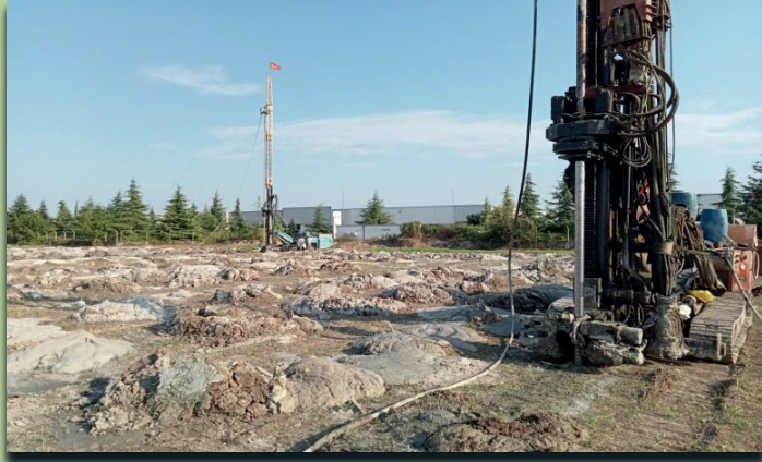
EREN HOLDİNG - GÜN İNŞAAT MODERN OLUKLU MUKAVVA AMBALAJ SAN.A.Ş.(2022) ADAPAZARI TESİSİ YATIRIMI TEMELALTI JETGROUT İMALATLARI
